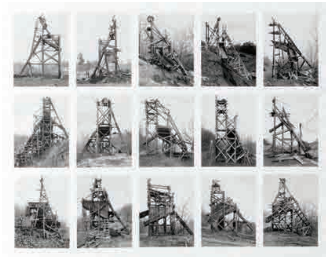
Figura 5_ Torres de Mina, Pennsylvania, Estados Unidos, 1974-1978.
