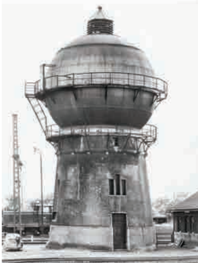
Figura 6_ Castelo d'água, distrito de Dorstfeld, Dortmund, Alemanha, 1965.
